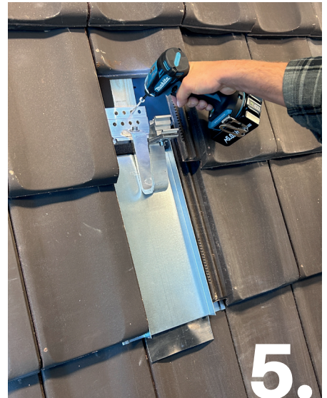
Dachhaken montieren.
