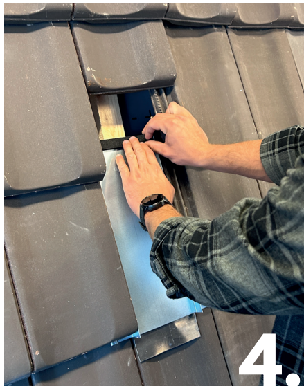
Dichtband anbringen.
